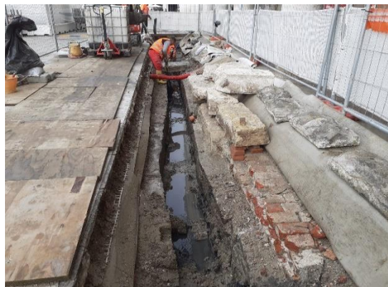
Risanamento del cunicolo fronte Palazzo Ducale
