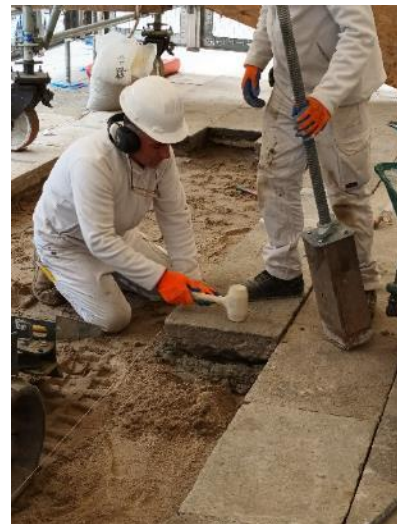
Nuova posa delle pavimentazioni
