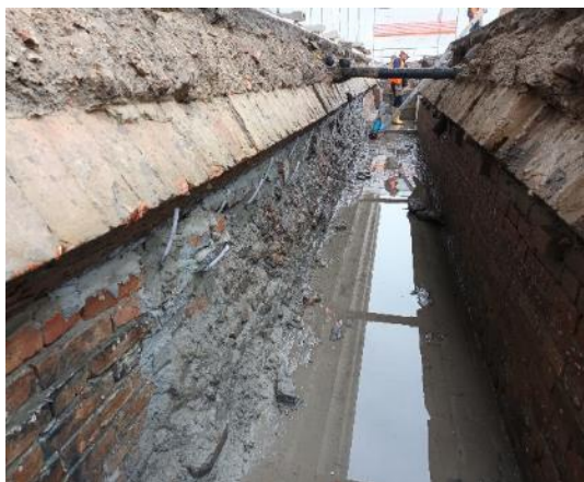
Risanamento dei cunicoli
