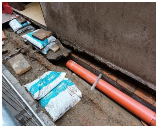
Riordino dei sottoservizi
